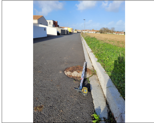
Vue de la référence nivellement : tampon d'eaux pluviales.
